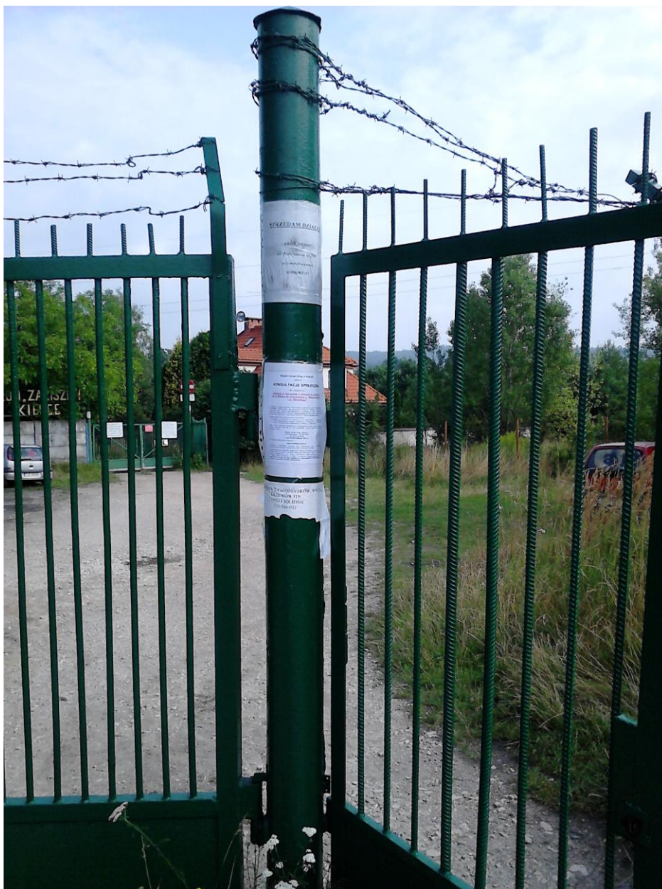
Fot. nr 5. Ogłoszenie na bramie wjazdowej do ogródków działkowych „Zacisze”
