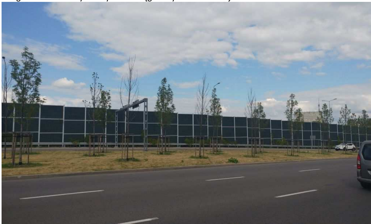
Fotografia 3 Ekrany akustyczne w ciągu ulicy Grunwaldzkiej
