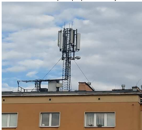
Fotografia 4 Stacje bazowe telefonii komórkowej na budynku przy ul. Żelaznej
