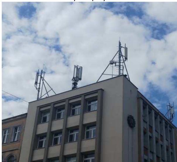
Fotografia 5 Stacje bazowe telefonii komórkowej na budynku przy ul. Sienkiewicza
