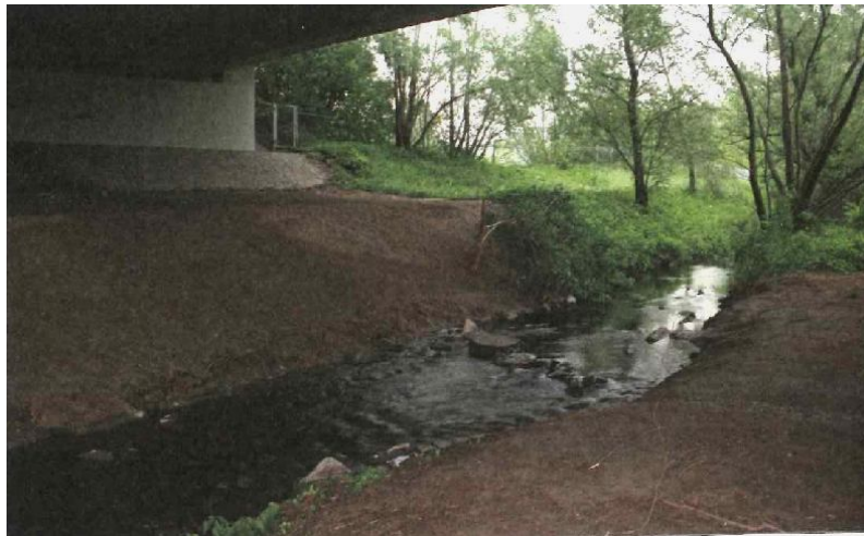
Fot. 6. Przykład naturalnie ukształtowanych skarp otwartego koryta rzeczno- biegnącego pod układem drogowym
