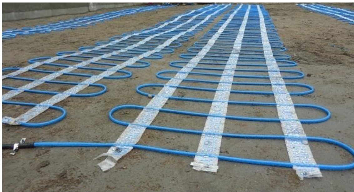
Rys. 43 Ogrzewanie przeciwołodziowe [80]
