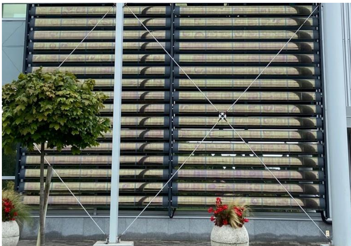
Rys. 20 "Łamacze światła" z ogniwami perowskitowymi produkcji Saule Technologies w Lublinie [48]
