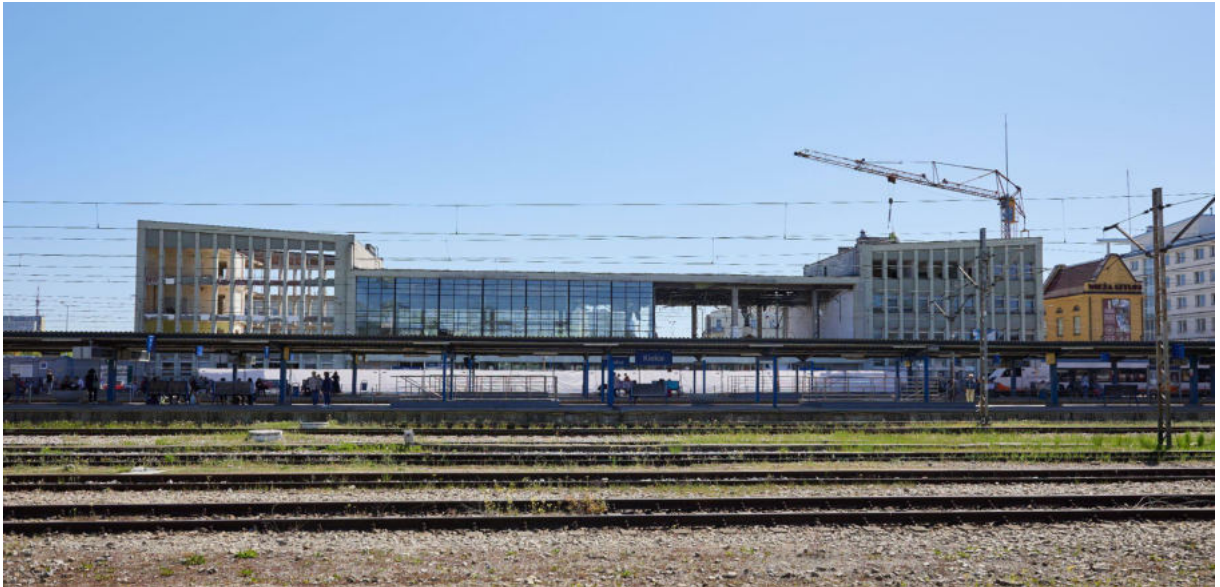
Rys. 16. Widok na dworzec w trakcie rozbiórki od strony ulicy Mielczarskiego
