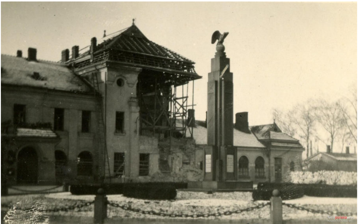
Rys.4 Uszkodzenia dworca w trakcie wojny, rok 1939
