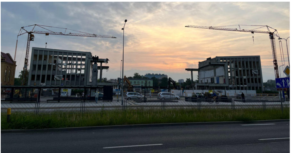
Rys. 17. Widok na dworzec po pracach rozbiórkowych od strony ulicy Sienkiewicza
