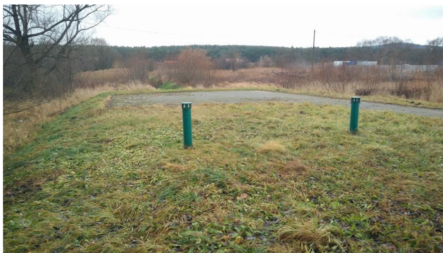
Fot. 1. Urządzenie hydrotechniczne w dolinie Silnicy przy ul. Krakowskiej (nasyp nr 22) (fot. A. Ratajski)
