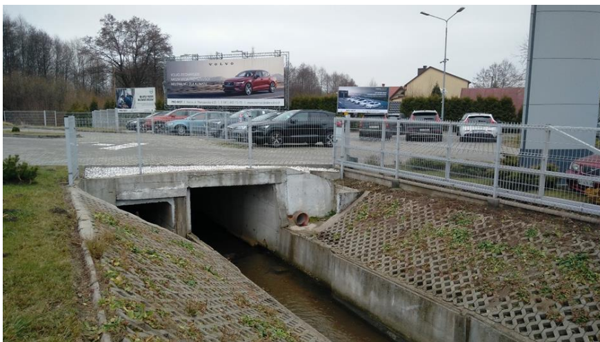
Fot. 4. Uregulowane i przekształcone koryto rzeczno Silnicy. Parking przy salonie samochodowym przy ul. Warszawskiej (fot. A. Ratajski)
