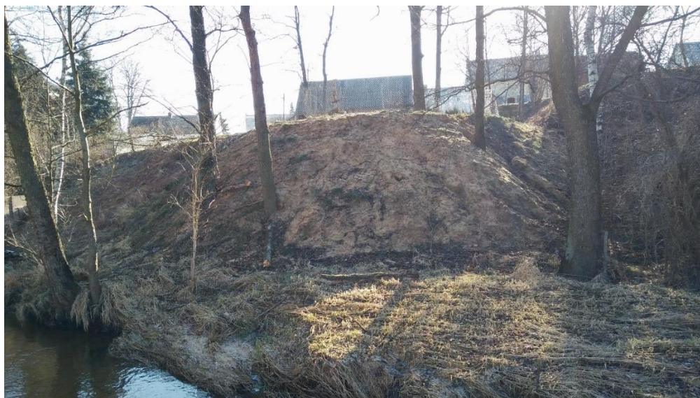
Fot. 3. Nasyp nr 52 na krawędzi doliny Sufragańca. Widoczne zasypanie materiałem podstawy pni drzew (fot. A. Ratajski)
